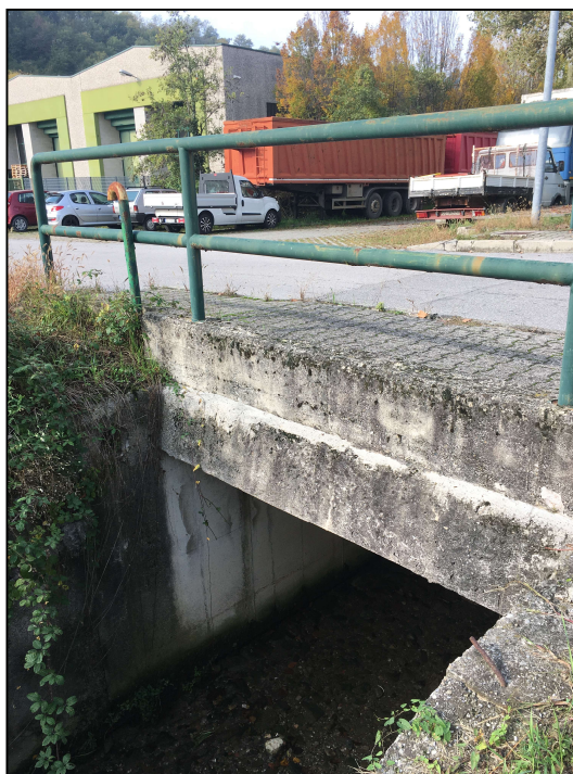
Immagine 5 – Attraversamento corso d'acqua su via delle Industrie (Foto 7 elaborato G.3)
