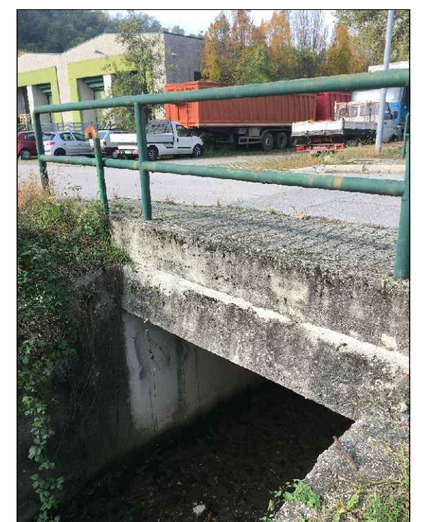
1 - Ponte via delle Industrie
