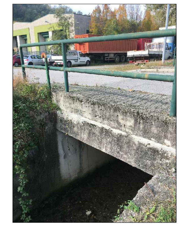
1 - Ponte via delle Industrie
