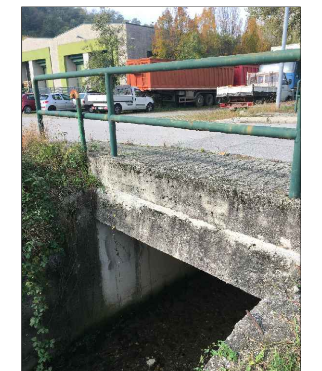
1 - Ponte via delle Industrie
